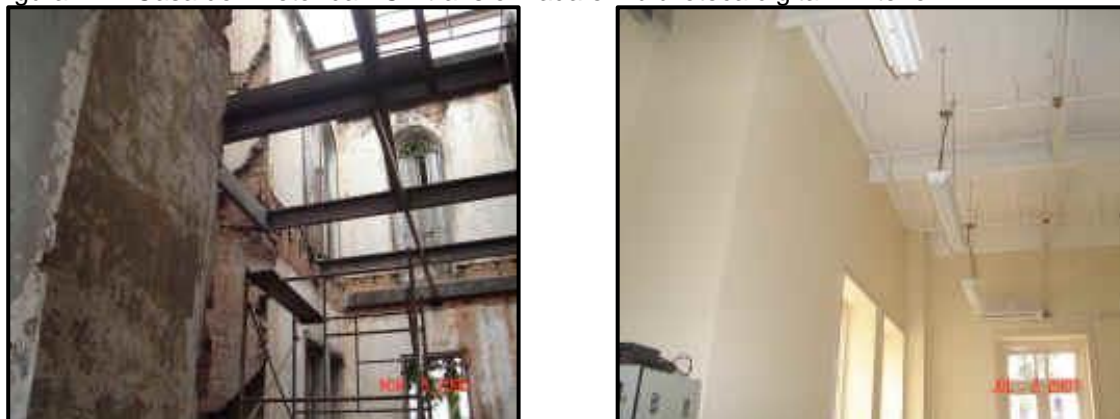
Figura 11 – Casa do Diretor da FCE transformada em biblioteca digital – interior
