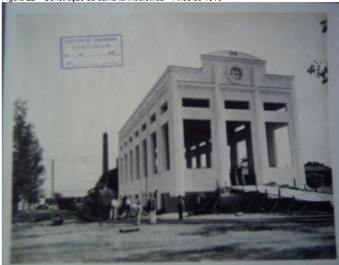
Figura 22 – Construção da usina termoelétrica – Anos de 1910
